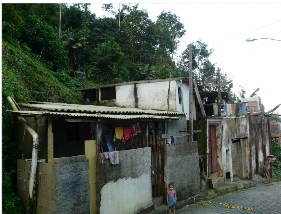
Foto CA-JA-01-02: Moradias de baixo padrão construtivo muito próximas ao talude de corte.
