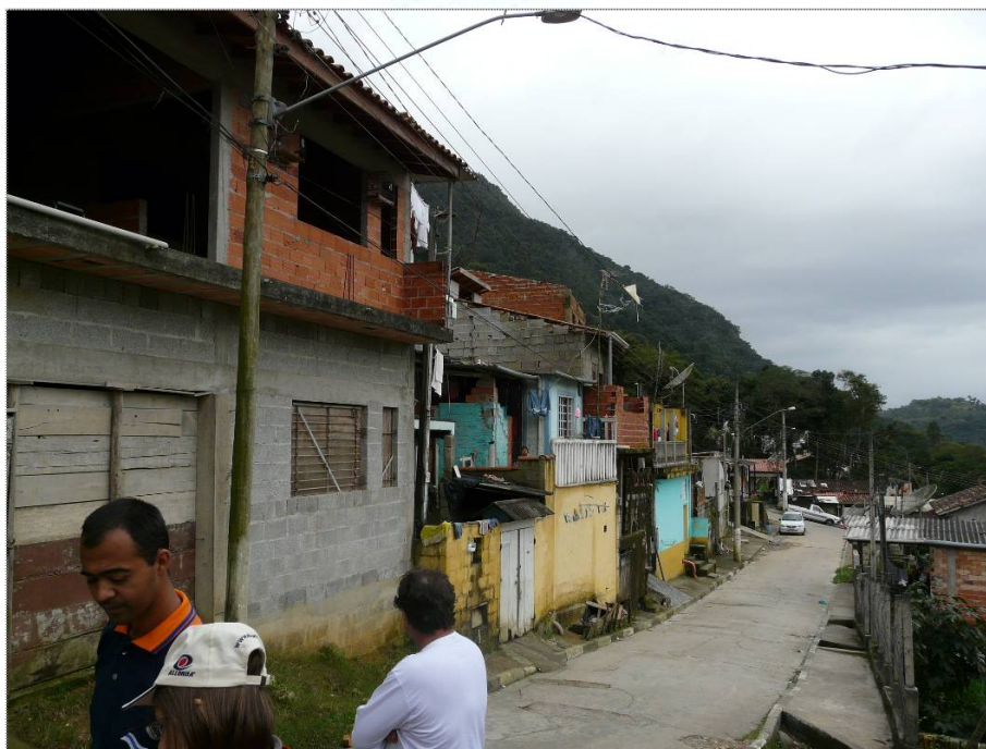
Foto CA-CB-05-02: Moradias na Rua Rosa Zait Cury. Observa Rua pavimentada.
