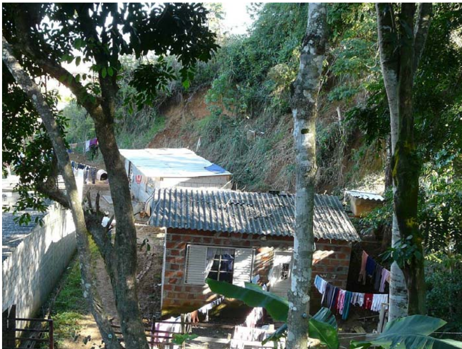
Foto 1 - Moradias a serem removidas localizadas no setor 1 do Jardim Califórnia. Observar cicatriz de escorregamento com material que atingiu o fundo das moradias.
