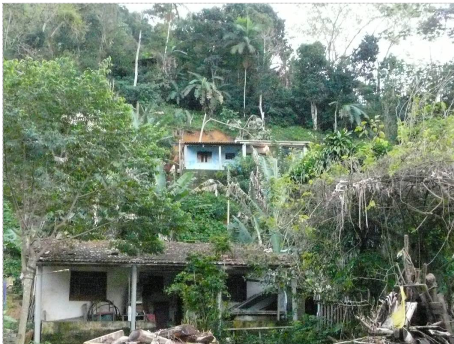
Foto CA-JA-02-01: Observar padrão construtivo das moradias do setor. Presença de cobertura vegetal.
