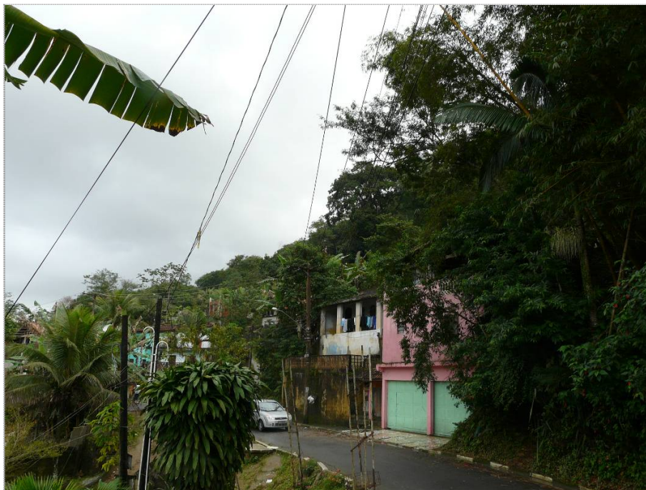
Foto CA-OL-04-01: Visão geral do setor com grau de risco médio.
