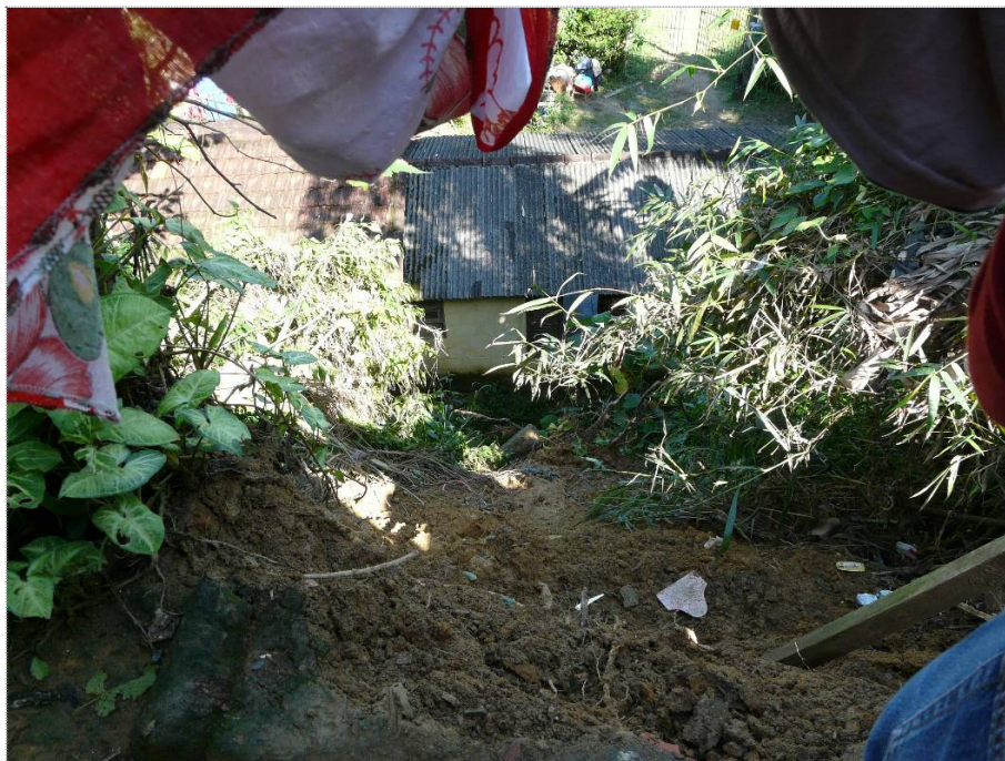
Foto CA-JA-07-03: Cicatriz de escorregamento. Observar o material mobilizando atingindo os fundos da moradia na base do talude.
