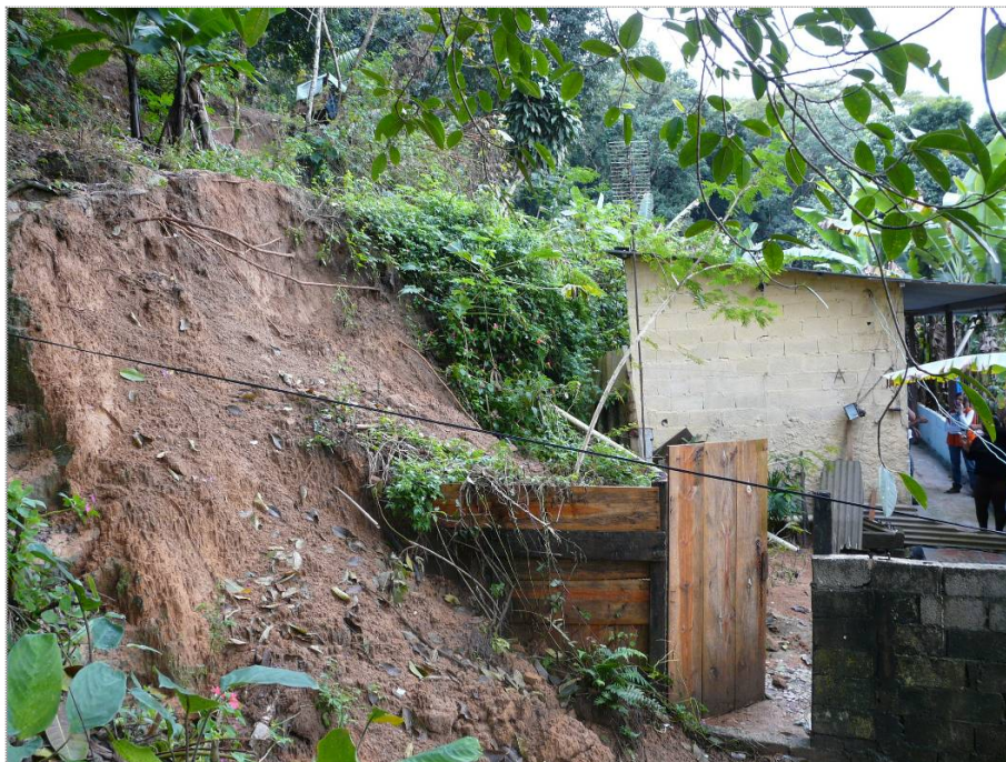
Foto CA-OL-03-03: Cicatriz de escorregamento. O material mobilizado atingiu parte dos fundos da moradia. Executar remoção da edificação.
