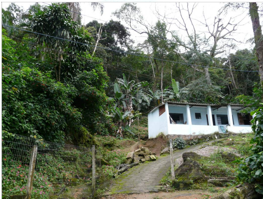
Foto CA-SU-01-02: Ocupação no setor ao sopé da encosta, sobre corpo de tálus. Este material apresenta risco de movimentos de massa, agravados por intervenções antrópicas por meio de taludes de corte.
