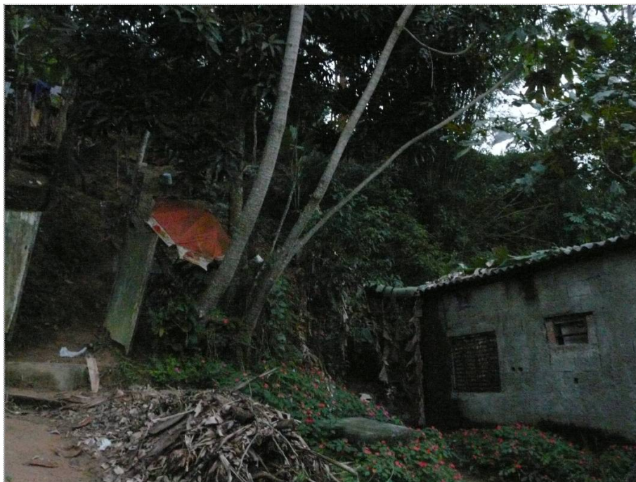
Foto CA-TI-02-03: Situação das moradias a ser removidas no setor de risco muito alto.
