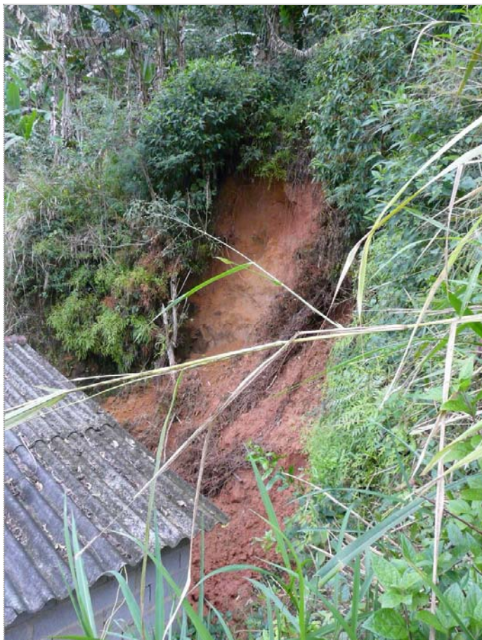
Foto CA-CG-02-03: Cicatriz de escorregamento atingindo os fundos da moradia.
