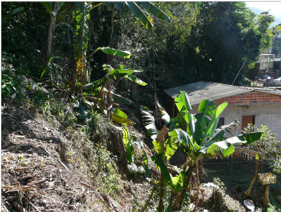
Foto CA-RO-03-02: Notar necessidade de limpeza, melhorias de acesso e drenagem superficial no setor.
