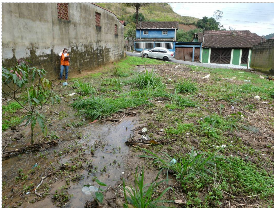
Foto CA-OL-05-02: Surgência d'água drenando para terreno não ocupado, sem cobertura vegetal.
