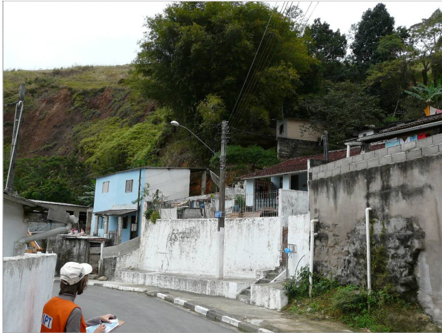
Foto CA-CB-06-01: Padrão de ocupação do setor. Observar proximidade das moradias à base dos taludes.
