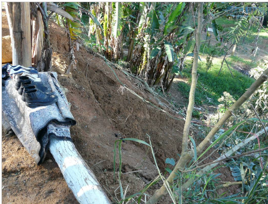
Foto CA-CL-01-03: Detalhe da cicatriz de escorregamento. Observar árvores inclinadas.
