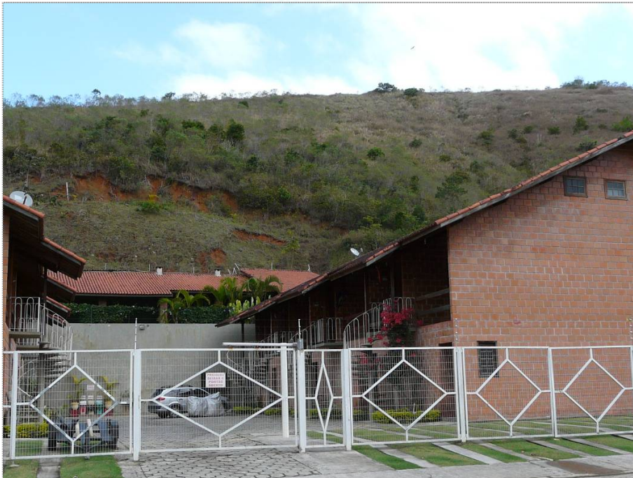
Foto CA-PR-03-02: Degrau de abatimento no talude localizado nos fundos do condomínio.
