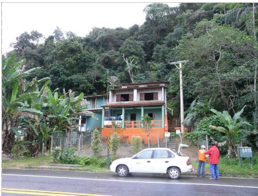
Foto CA-CO-01-01: Vista de parte do setor. Notar ocupação de alvenaria com bom padrão construtivo na base da encosta natural.
