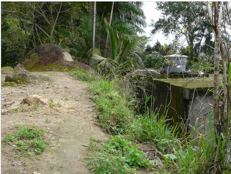
Foto CA-CB-02-02: Proximidade da moradia em relação aos blocos e matacões e ao talude de corte.
