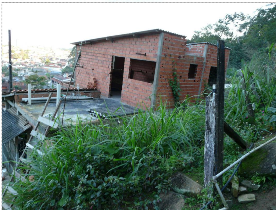
Foto CA-BE-03-02: Moradia próximas à base do talude de corte.
