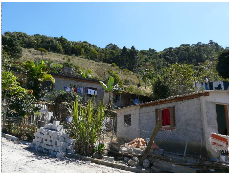
Foto CA-SR-01-02: As intervenções de cortes e aterros neste setor são de pequena monta e não propiciam a ocorrência de processos perigosos de instabilização de encostas.
