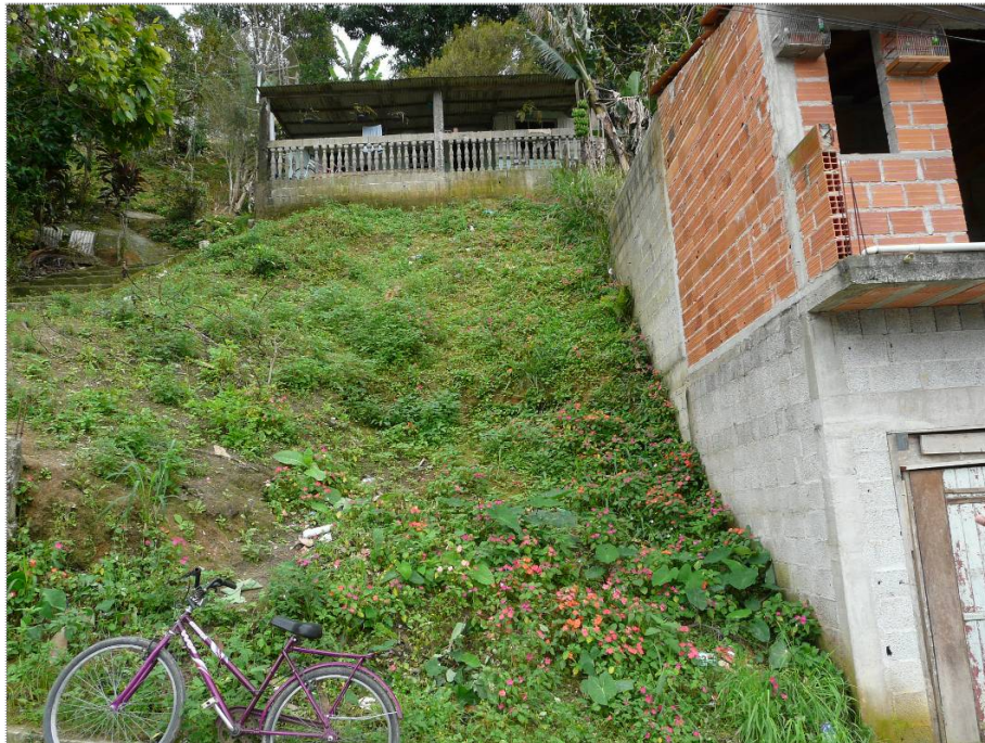
Foto CA-CB-06-02: Observar altura e inclinação do talude e a proximidade das moradias ao topo e base deste talude.
