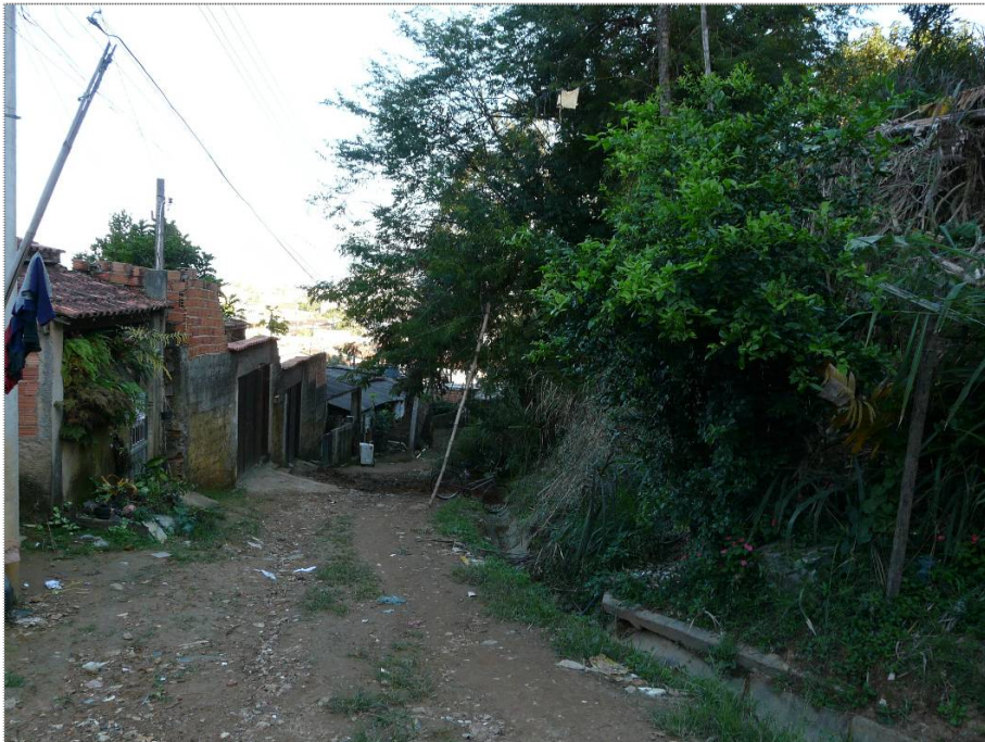
Foto CA-BE-01-02: Nota-se acúmulo de lixo, entulho e restos vegetais na via de acesso à área, não pavimentada.
