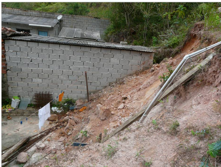
Foto CA-CB-07-02: Processo de escorregamento em talude no setor.
