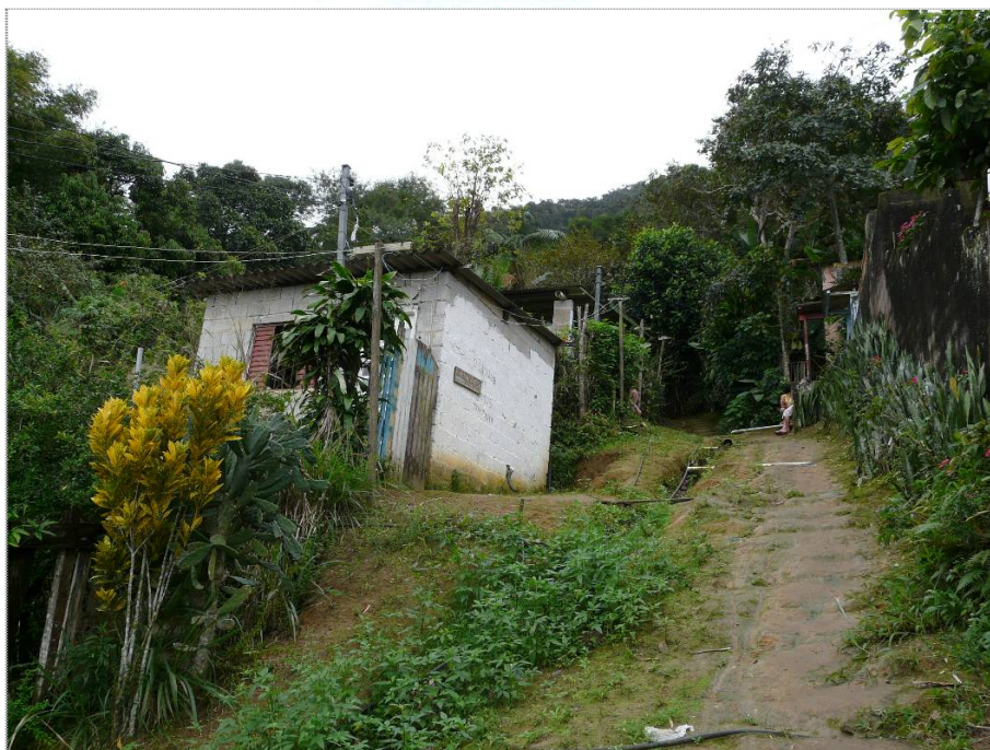
Foto CA-CB-01-04: Observar posição da moradia em relação a encosta natural que apresenta altura e declividade acentuada.
