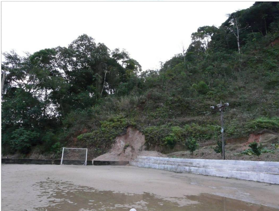
Foto CA-CJ-01-02: Escorregamento ocorrido próximo à área recreativa do condomínio.
