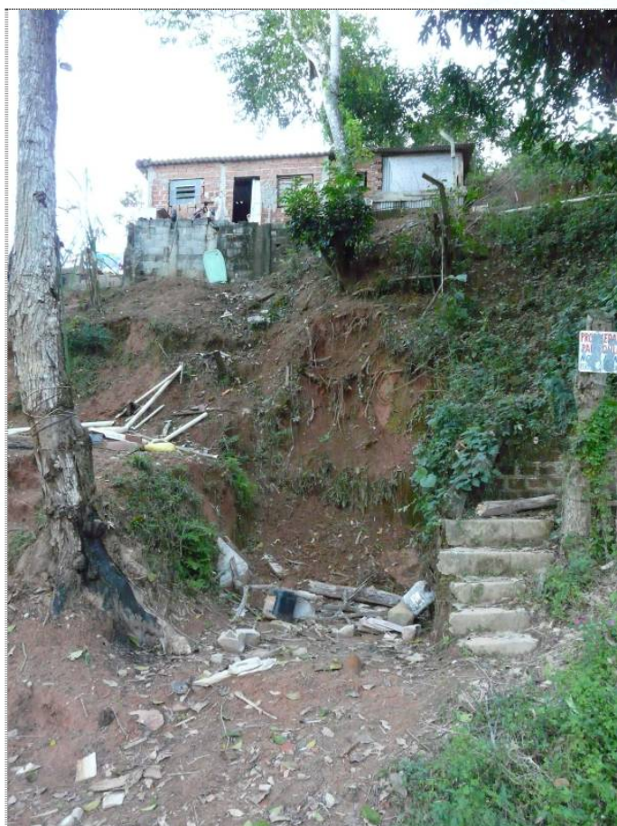
Foto CA-BE-01-03: Padrão de ocupação do setor. Notar proximidade da moradia ao talude de corte com solo exposto.
