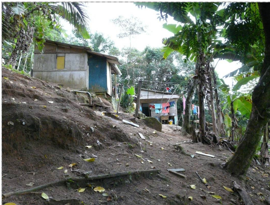
Foto CA-CB-01-01: Padrão precário de ocupação do setor. Nota-se a exposição do solo e sinais de instabilidade.
