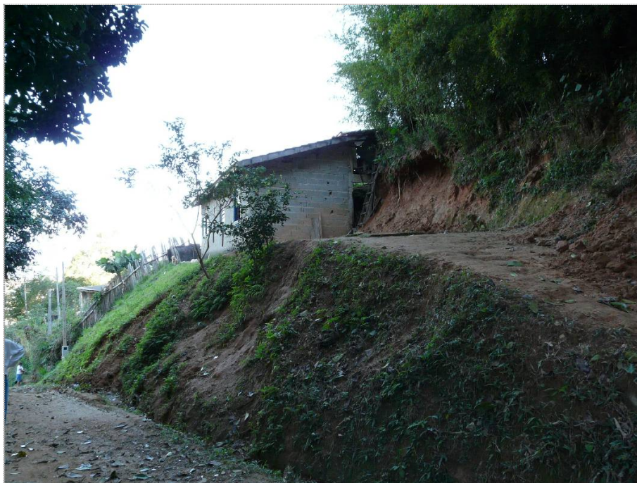
Foto CA-BE-01-03: Padrão de ocupação do setor. Notar proximidade da moradia ao talude de corte com solo exposto.
