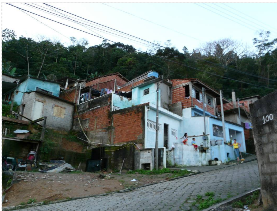
Foto CA-JF-01-01: Observar padrão construtivo das moradias do setor.
