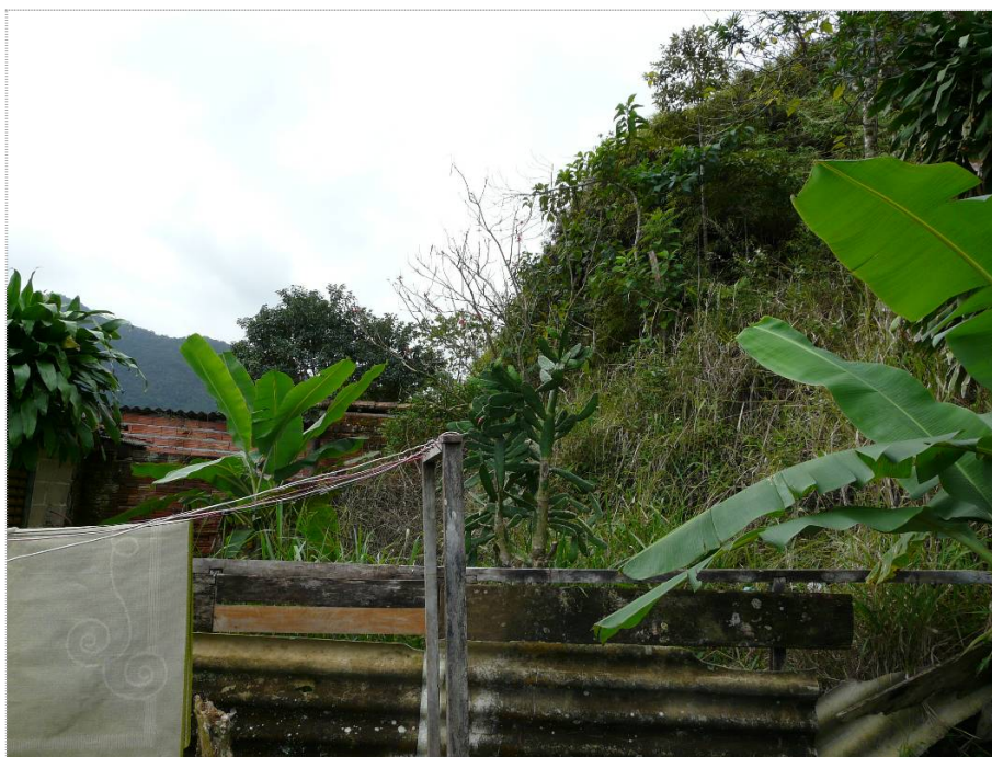
Foto CA-MS-02-01: Observar proximidade da moradia à base do talude.
