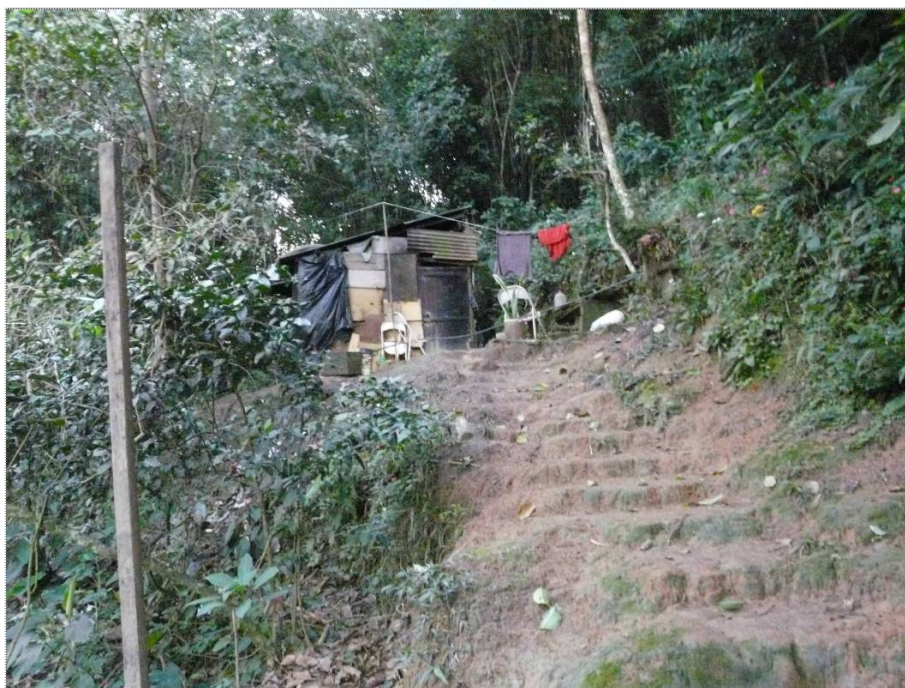
Foto CA-JF-01-02: Moradia muito precária em encosta de altura e inclinação excessiva. Sugere-se sua remoção.
