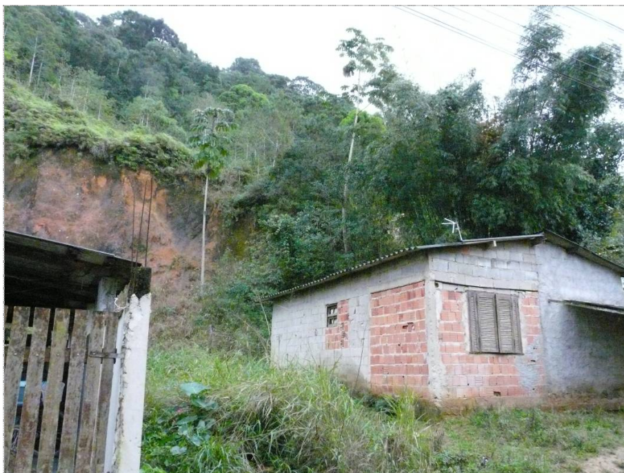
Foto CA-ST-01-03: Notar o espaço disponível para reocupação da área de forma a repositonar as edificações com seu eixo maior em paralelo com a rua e distante dos taludes de corte.
