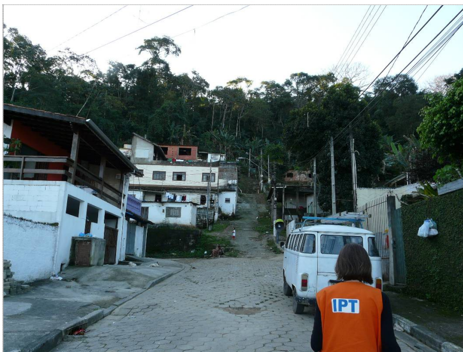
Foto CA-BE-03-01: Padrão das moradias do setor. Observar altura e inclinação da encosta natural. Vias de acesso parcialmente pavimentadas.
