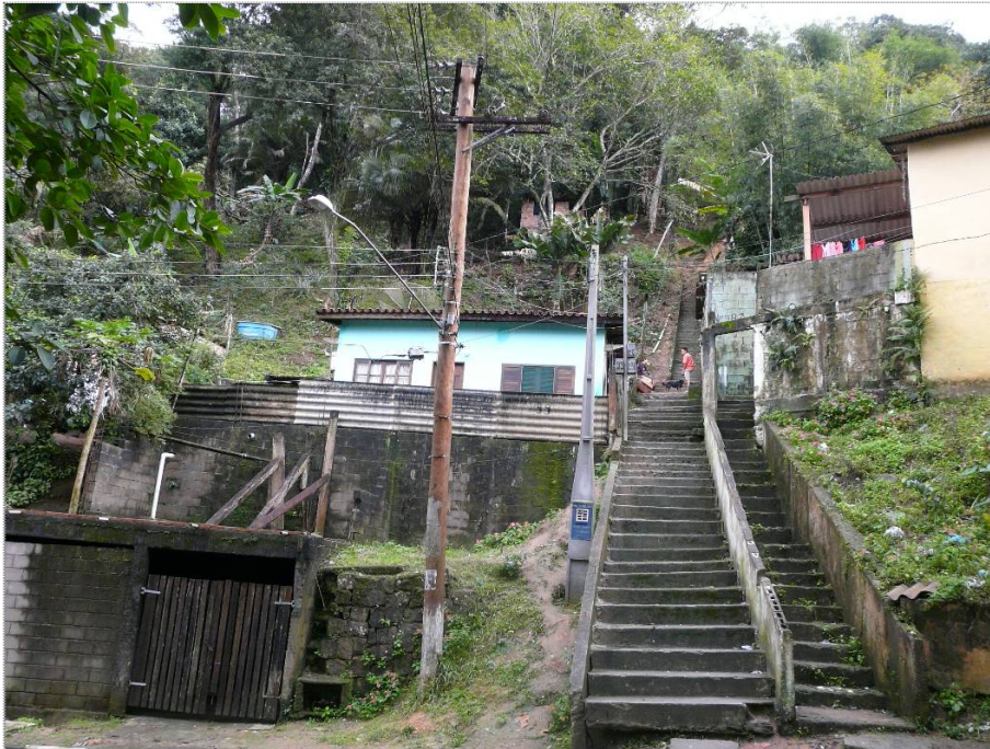
Foto CA-OL-03-01: Vista geral do setor com grau de risco muito alto. Observar altura e inclinação da encosta natural.
