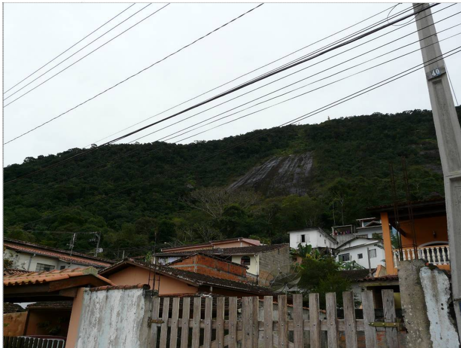
Foto CA-SU-01-01: Padrão de ocupação do setor. Notar a encosta natural ao fundo com maciço rochoso exposto, escoamento superficial e cicatrizes de antigos escorregamentos.
