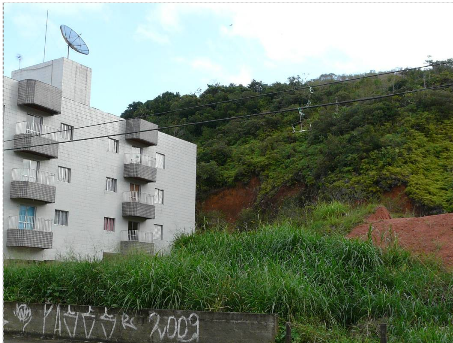
Foto CA-PR-01-01: Proximidade do condomínio ao talude de corte. Observar cicatrizes de escorregamentos.
