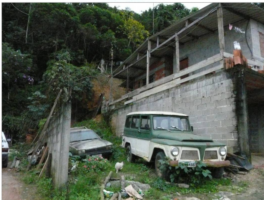
Foto CA-TI-01-02: Notar a proximidade do talude de corte e encosta natural ao fundo da moradia.
