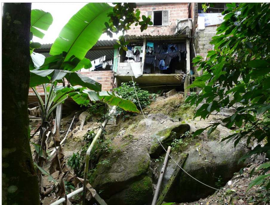
Foto CA-CB-04-02: Blocos e maticões na base das moradias do setor.
