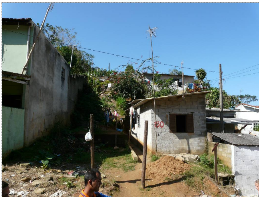
Foto CA-JA-05-02: Situação dos taludes de corte no setor.
