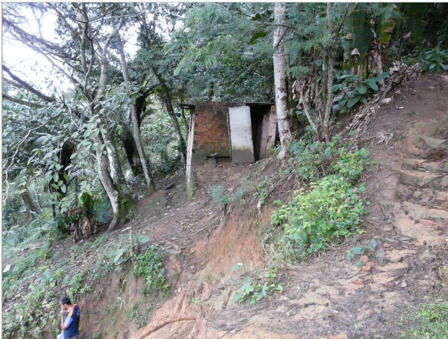
Foto CA-OL-03-02: Observar posição da moradia em relação à encosta que apresenta alta declividade, cicatriz de escorregamento e presença de vegetação.
