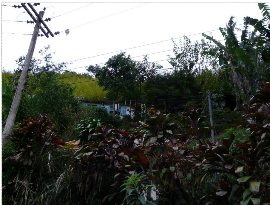
Foto CA-SE-01-01: Única moradia ocupando encosta natural de alto risco de escorregamento no setor.
