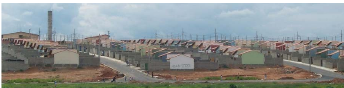
FIGURA B.2 - Campo dos Alemães: (a) Setor com tipologia homogênea das edificações e (b) foto do bairro.
