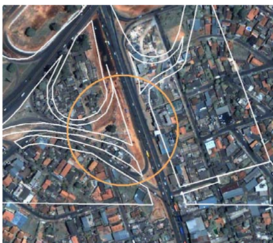
Figura 5.8 – Imagem da área preparada para execução do alargamento.
