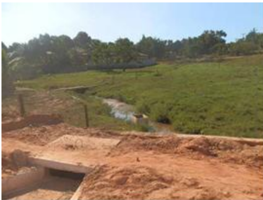
Figura 59 – Vista parcial de área de Loteamento; via sendo construída pelo aterramento de igarapé.
