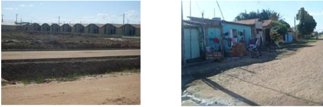
Figura 5: Vista do empreendimento Vale do Tocantins, e de rua no núcleo de São Félix.
