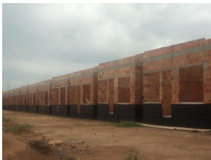
Figura 3 - Unidades Habitacionais em construção
