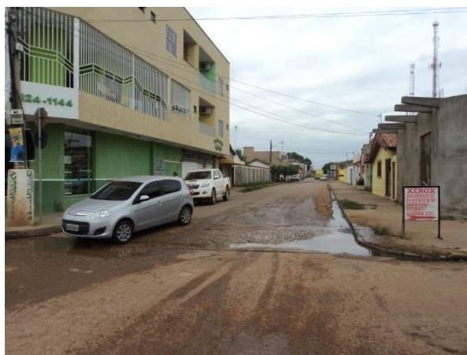
Figura 3 - Condições de Infraestrutura
