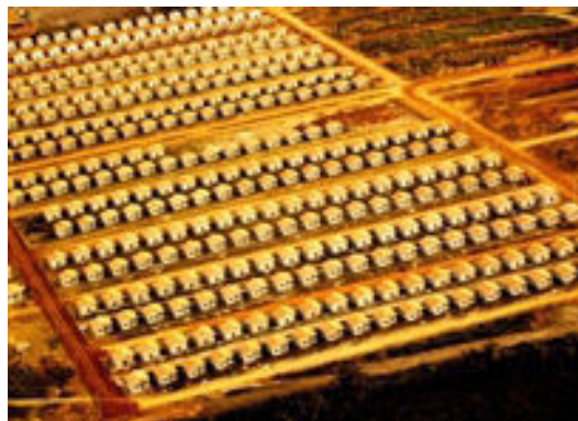
FIGURA 46: Bairro dos Minérios
