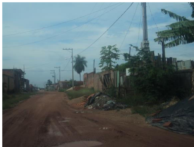
Figura3 - Condição de Infraestrutura Fonte:Taynara Gomes, 2013
