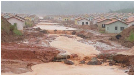
FIGURA 11: Alagamento no Residencial Salvação após chuvas intensas em março de 2014
