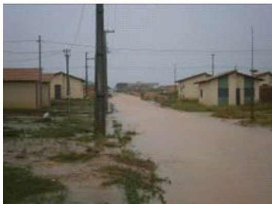
FIGURA 55: Alagamento no empreendimento “Vale do Tocantins”, após o início do período chuvoso em Marabá.
