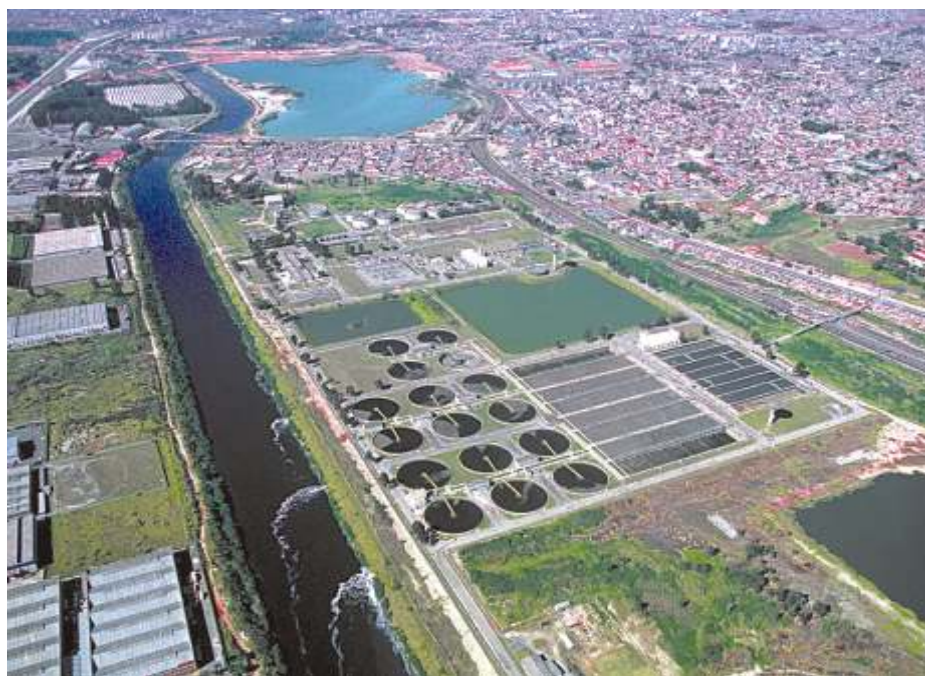
Figura 3: Estação de tratamento de esgoto as margens do Rio Tietê em Barueri (SP) em risco de perdas físicas, econômicas e ambientais em caso de transbordamento do rio.
